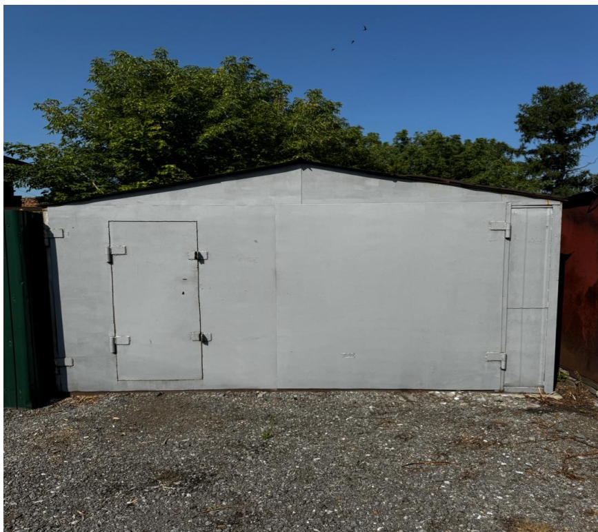
Временный металлический гараж, размещенный вблизи многоквартирного дома по адресу: г. Омск, ул. Учебная, д. 3 (Акт № 357)
