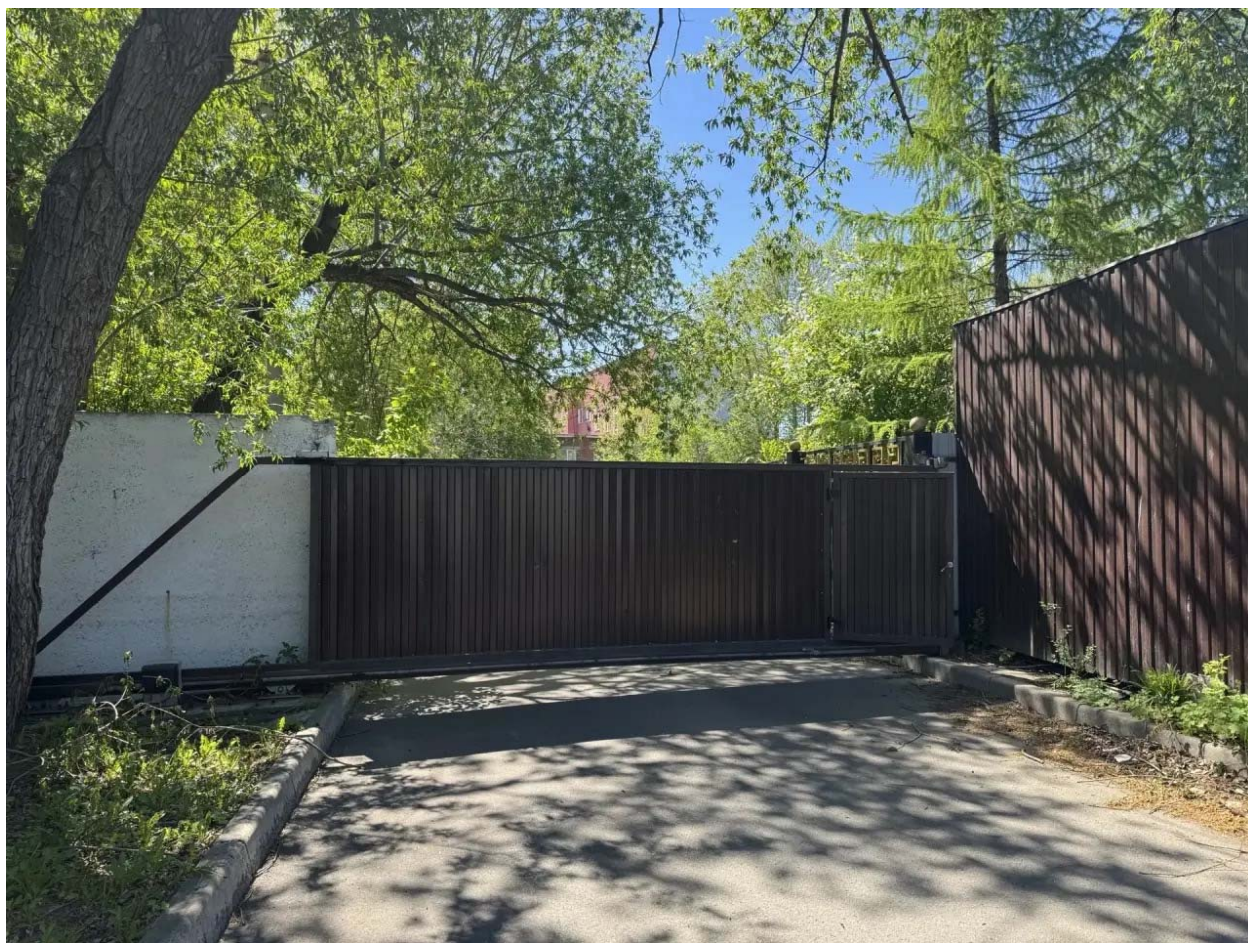
Ограждение, размещенное вблизи строения по адресу: г. Омск, ул. 2-я Судоремонтная, д. 9к1 (Акт № 3)
